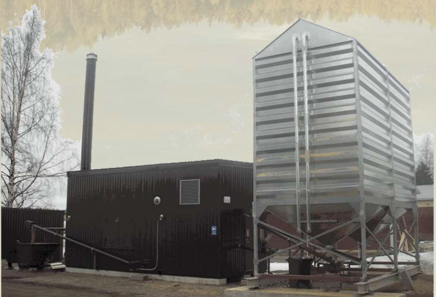
Teollisuuslaitos (pelletti) 800kW / TiiMi 7310
